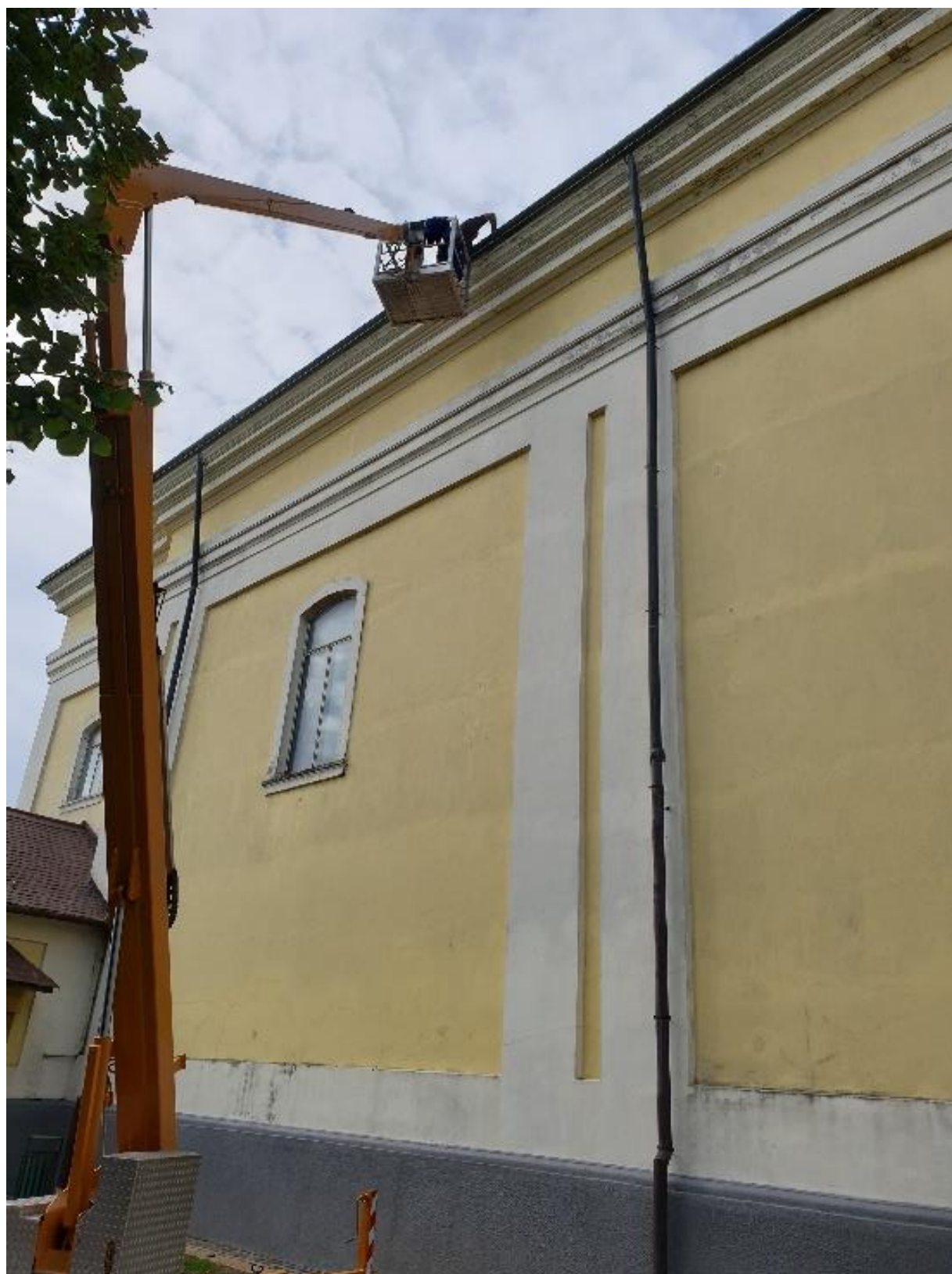
Bádogozás és a fekvőcsatorna javítása emelőkosárból
