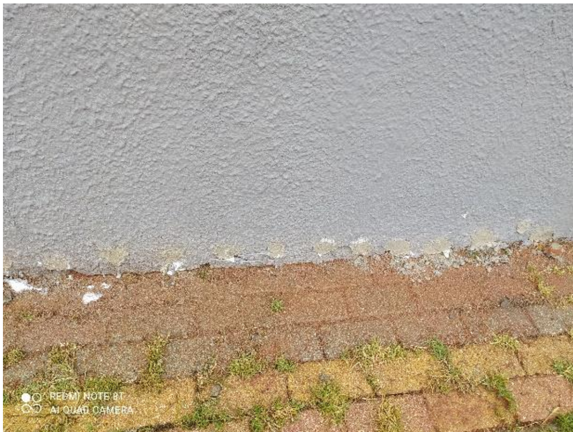
Vakolat és festékJavítás az injektálás után
