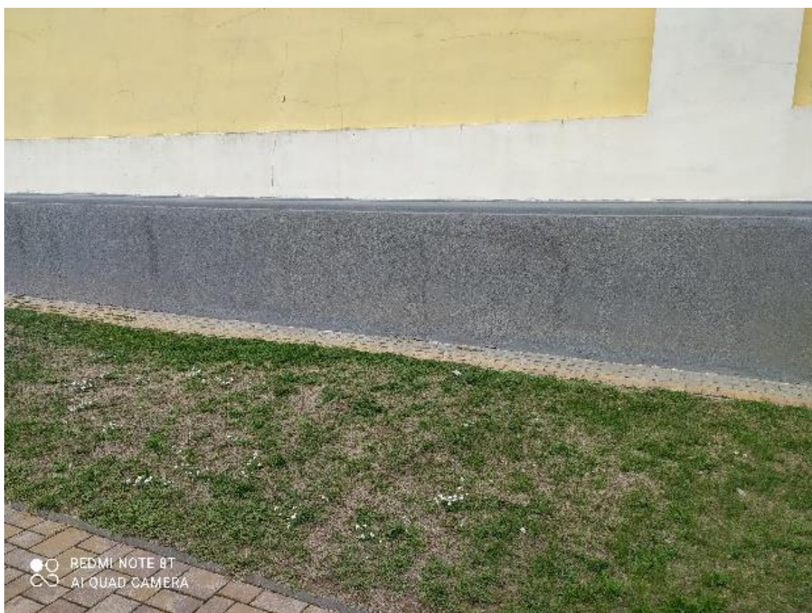
A kijavított és újrafestett lábazat
