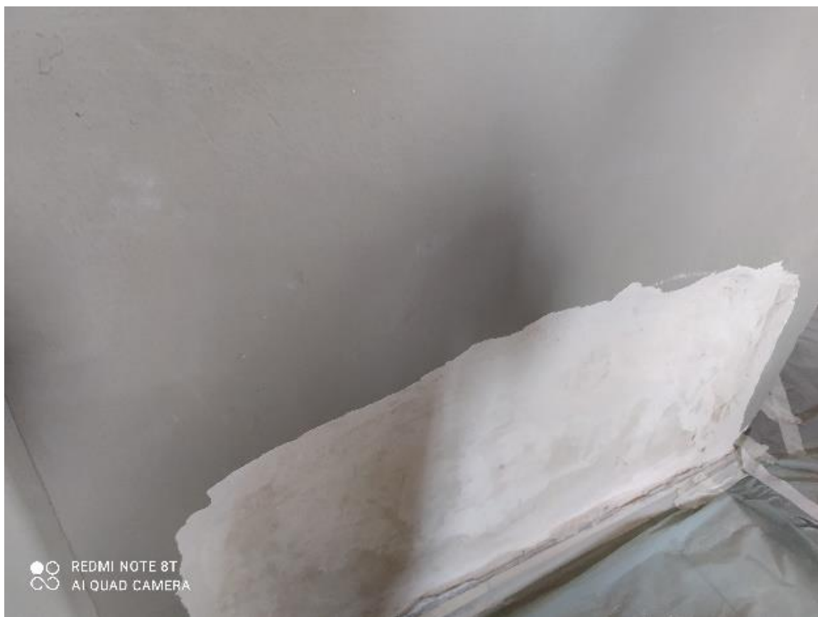
A kijavított és újrafestett lábazat
