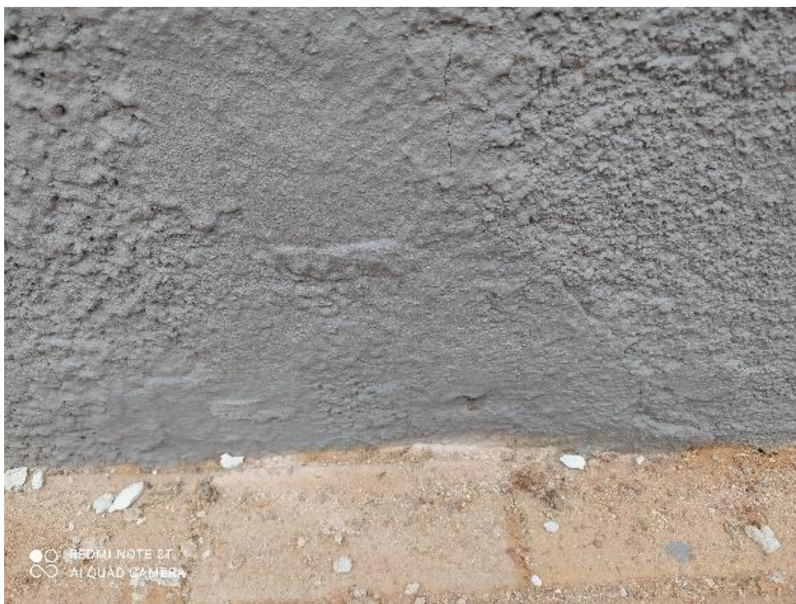
Vakolat és festékJavítás az injektálás után
