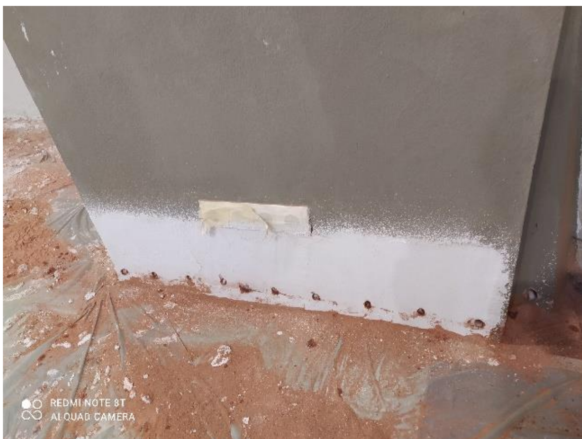
Talajnedvesség elleni szigetelés falinjektálás módszerrel
