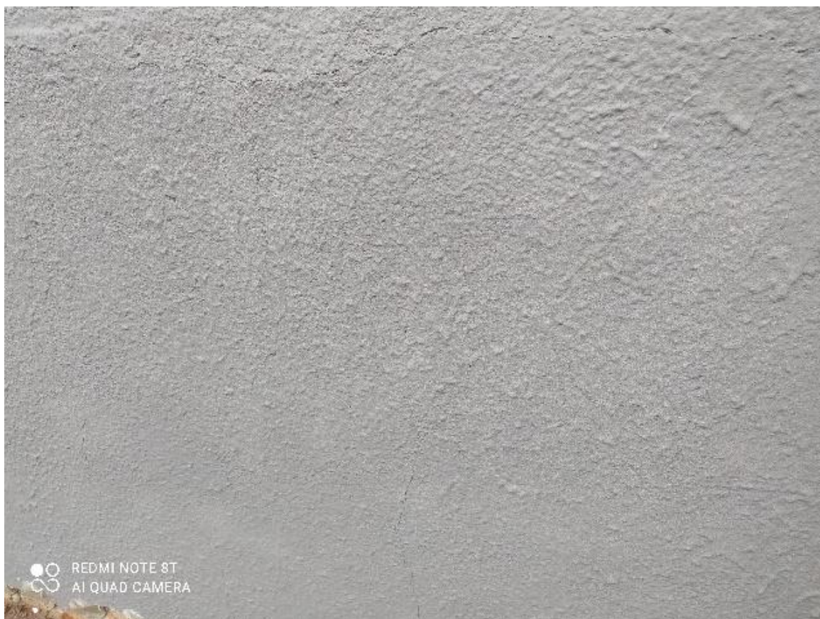
Csapadékvíz elvezető csatorna részleges javítása, pótlása
